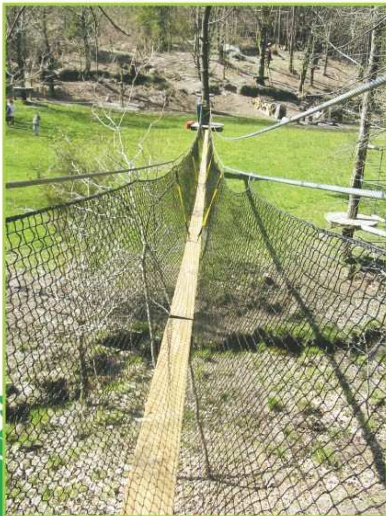
Filet d'habillage en polyéthylène coloris noir, fil 1,8 mm, mailles carrées de 40 mm, avec surjet de renfort sur la périphérie.
